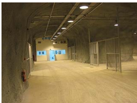
Υπόγειος χώρος διάθεσης ειδικών αποβλήτων
