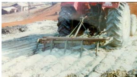
Αποκατάσταση φράγματος απόθεσης τελμάτων
