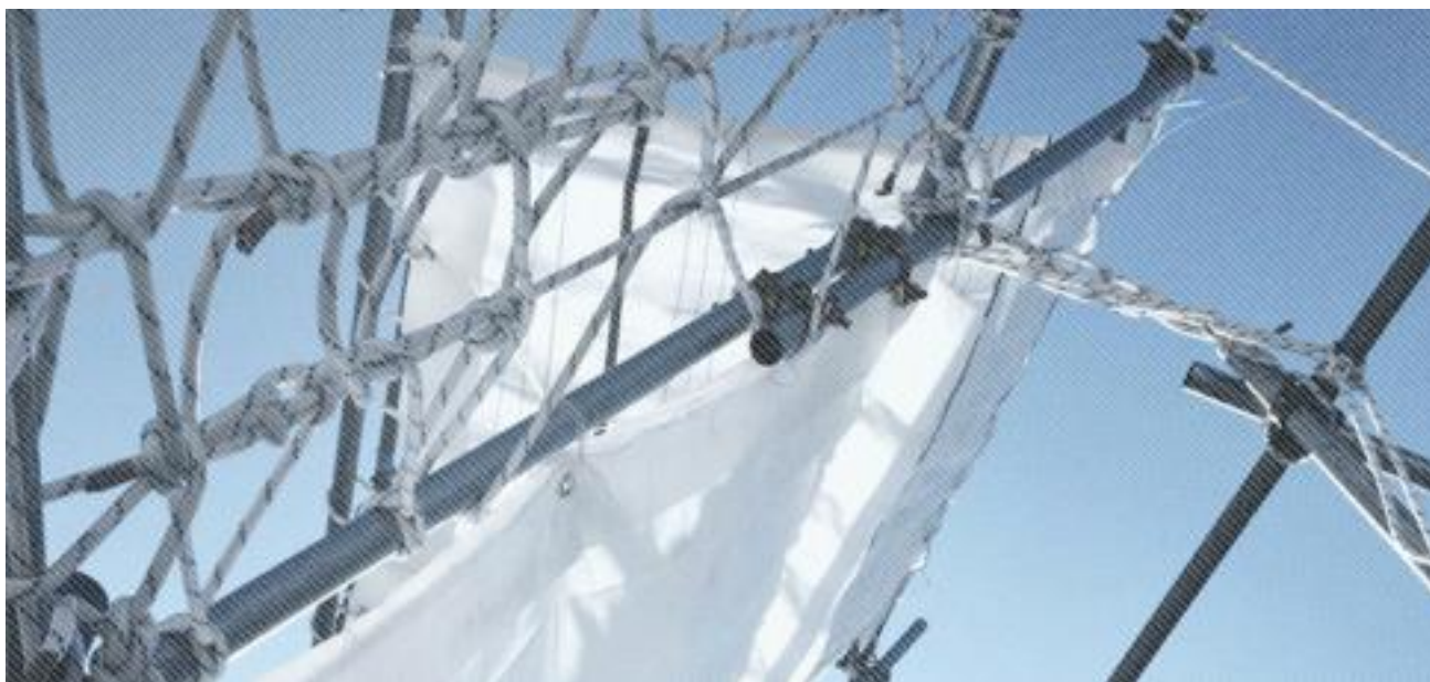
Εικόνα 9. Άποψη κατασκευής μονάδας κατοίκησης
