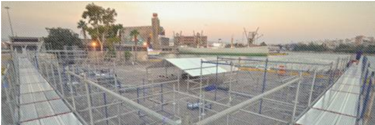
Εικόνα 8. Άποψη του χώρου στο λιμάνι του Πειραιά με τα μεταλλικά ικριώματα- πλαίσια, πριν την εγκατάσταση των ελαφριών κατασκευών
