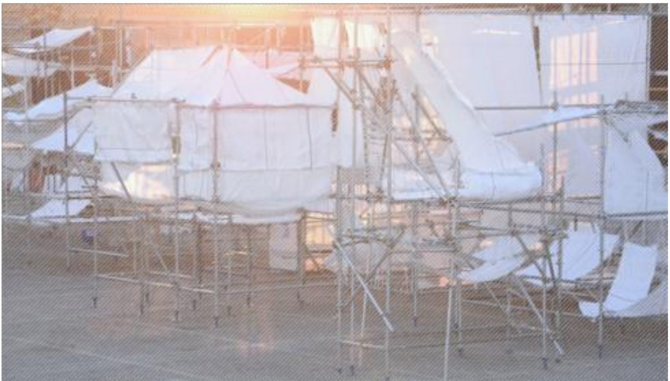
Εικόνα 12. Άποψη κατασκευής μονάδας κατοίκησης
