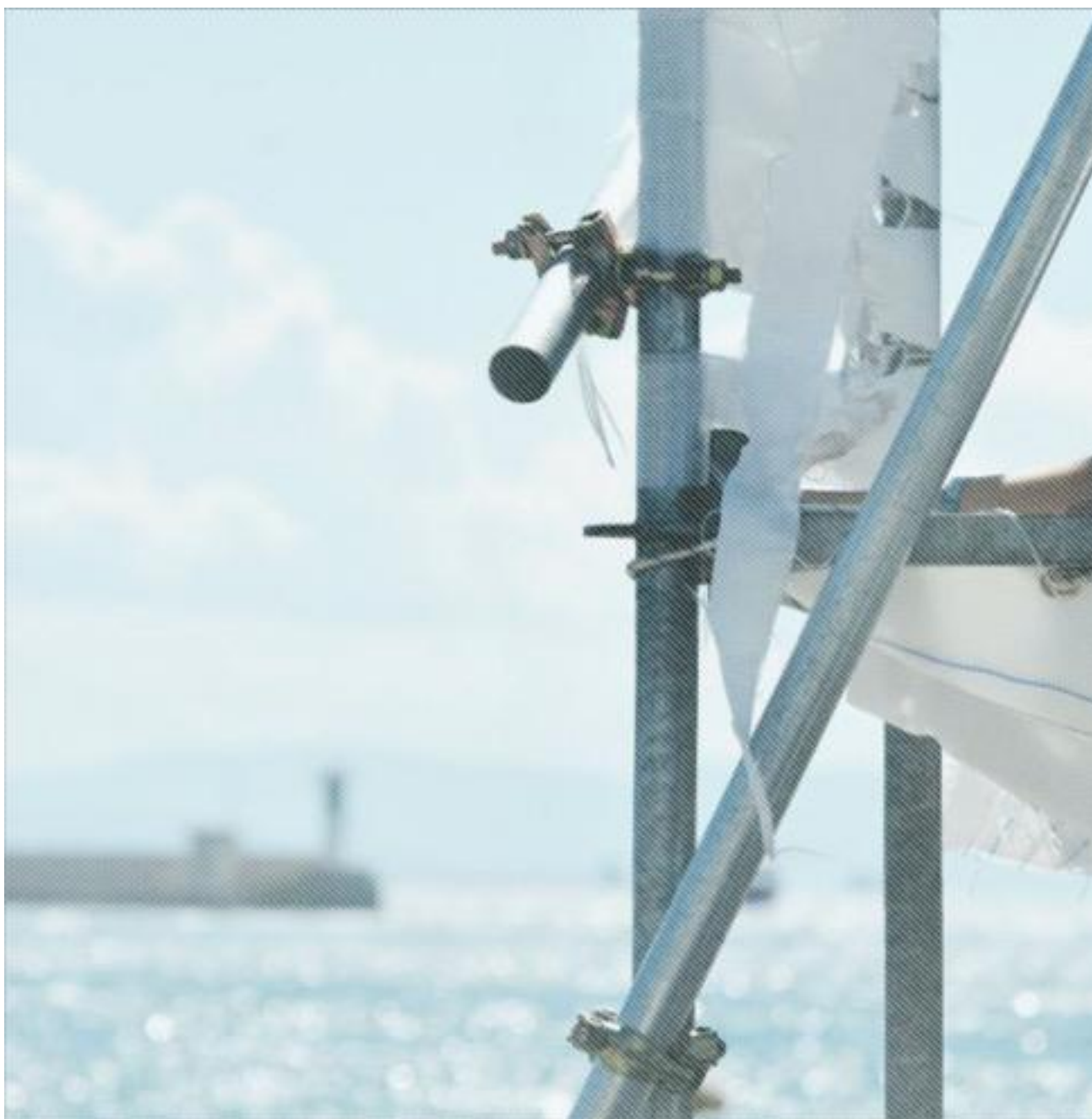
Εικόνα 1. Στιγμιότυπο κατασκευής στο λιμάνι του Πειραιά
