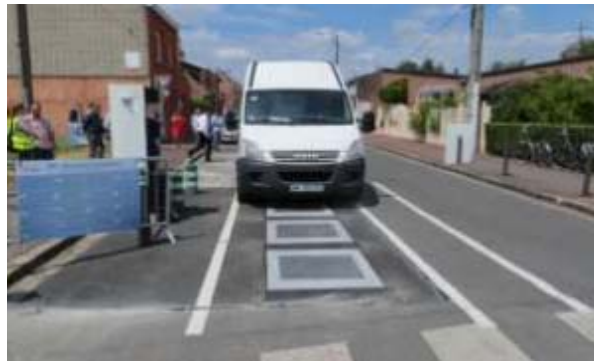
Εικόνα5: Ειδική διαγράμμιση για την ελαχιστοποίηση της οριζόντιας μετατόπισης των μαγνητικών συζευκτών [Πηγή: FastInChargeProject]
