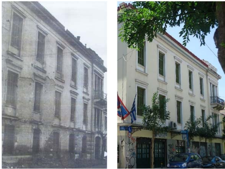
Εικ. 7: Παλαιότερη φωτογραφία (Αρχείο Δήμου Αθηναίων) και πρόσφατη φωτογραφία της κύριας όψης της Βίλλας Δουρούτη. Φαίνονται οι διαφορές στη διάταξη και στις διαστάσεις των ανοιγμάτων.
