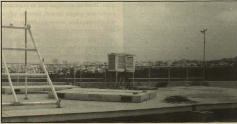
Πλατφόρμα στο Δώμα του Ηλιακού Εργαστηρίου
