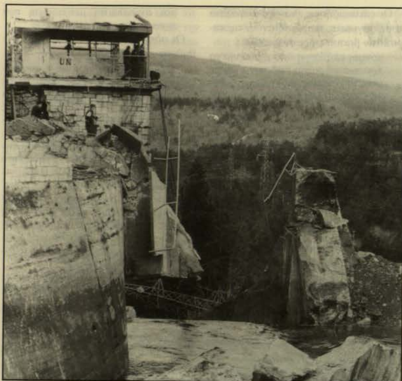
Φράγμα Peruca, Κροατία.
