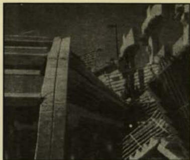
Φωτ. 9. Πολυώροφο προκατασκευασμένο πάγκιν στο Νόρθριτζ. Κατάρρευση ύστερα από μετασεισμό.
