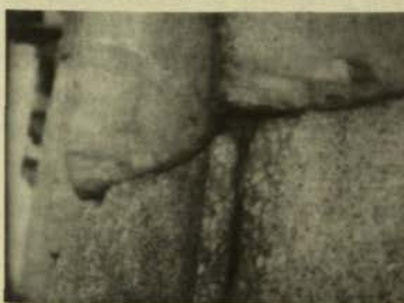
Σχ. 2,3. Διαδοχική φάση ρηγματώσεως του μετετόν και του μαρμάρου από διάβρωση σιδηροπλισμού. Λεπτομέρεια κίονα Παρθενώνα από αναστήλωση Μπαλάνου.
