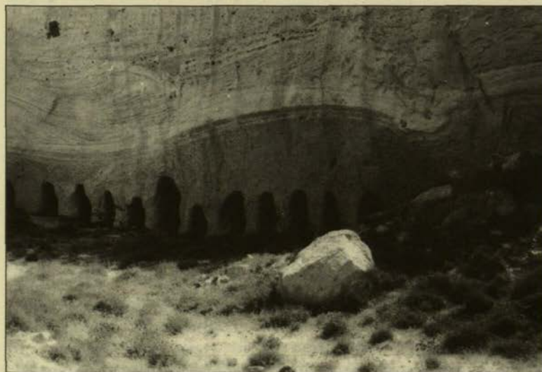
Σχ. 6: Είσοδοι των στοών υπονομεύσεως. Είναι χαρακτηριστικό το επίμηκες σχήμα τους, το οποίο αποκλίνει σημαντικά από τις συνήθεις διατομές στοών.
