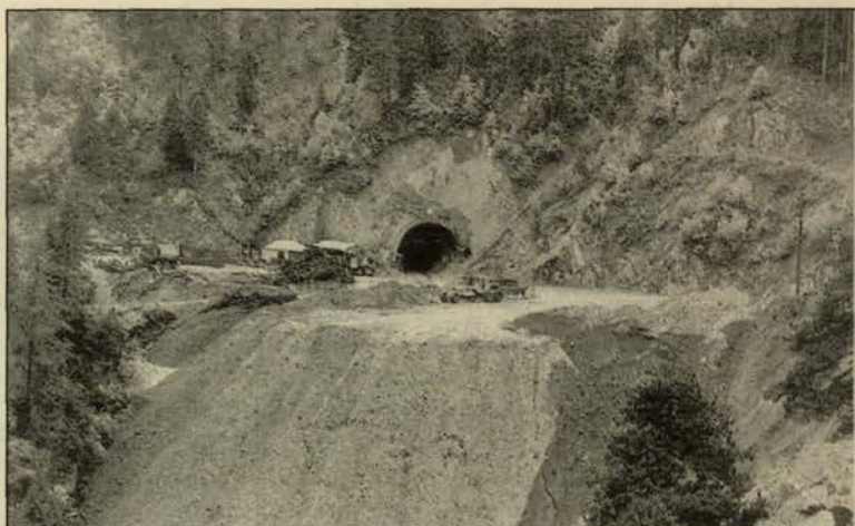
Σύραγγα Μετσόβου (Ανατολική πλευρά)
