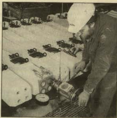
Έλεγχος της προέτασης με δυναμόμετρο
