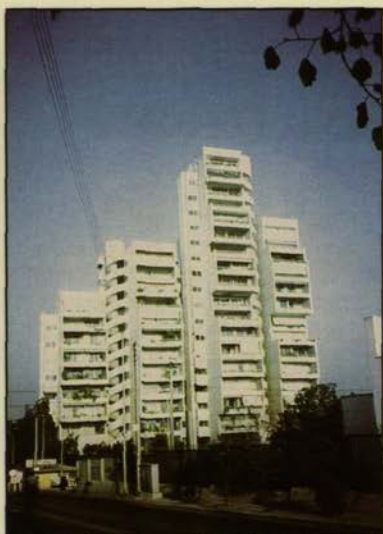
Domus 2000 (Αγία Βαρβάρα Χαλανδρίου). Ο φέρων οργανισμός συμβάλλει αποφασιστικά στη μορφολογία του έργου.
