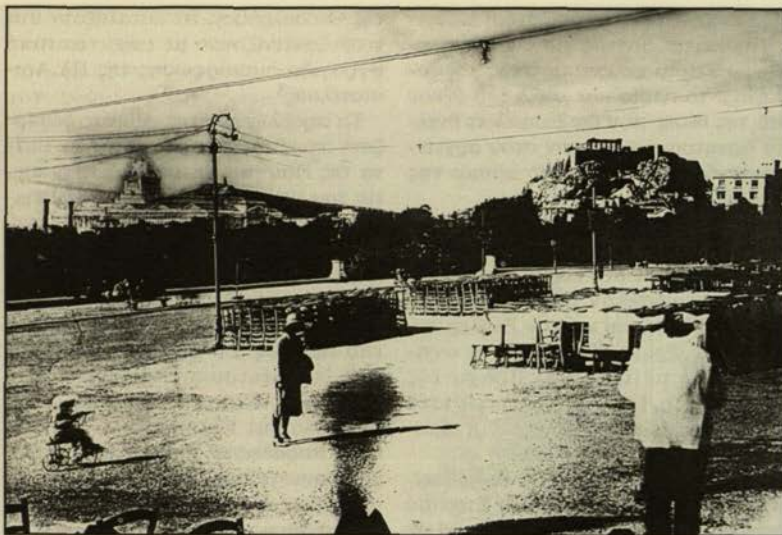
1930: Φωτομοντάζ από το Ζάππειο με το Δικαστικό Μέγαρο (φωτ. εποχής του αρχιτ. Αλ. Νικολοΐδη).
