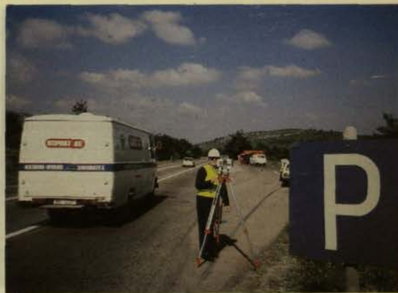
Αποτύπωση γεωμετρικών χαρακτηριστικών της Εθνικής Οδού Αθηνών - Λαμίας στο πλαίσιο Ερευνητικού Προγράμματος (περιοχή Συγκοινωνιακών Έργων).
