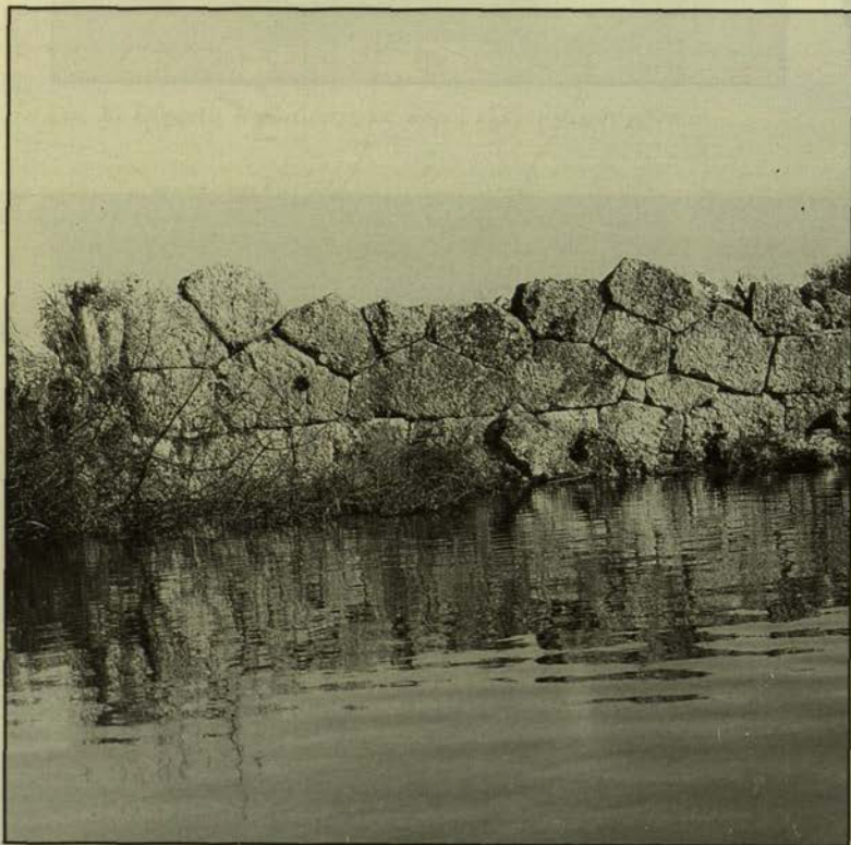
Εικ. 33α, β. Ρούγα (αρχαίος Εχίνος ή Ηράκλεια). Πολυγωνικό σύστημα δόμησης του τείχους.
