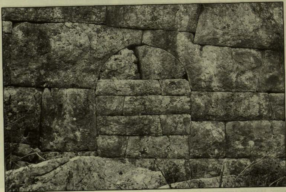
Εικ. 25. Αμφιλοχία. Αρχαία Λιμναία. Τειχιωμένη από την αρχαιότητα τοξωτή πύλη του τείχους.
