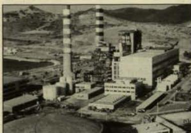
χώρους των μονάδων I και II του πλαισίου πετρελαιϊκού σταθμού των 150 MW και 300 MW που λειτουργεί με πετρέλαιο μαζούτ, και στους χώρους των μονάδων III και IV του
