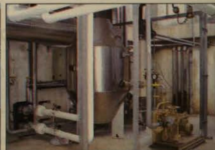
Εγκαταστάσεις ανάκτησης θερμότητας καυσαερίων, παραγωγής και διανομής ατμού.
