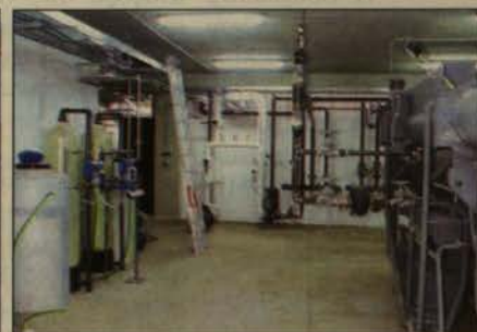
Εγκαταστάσεις παραγωγής ψυχρού νερού, διανομής νερού, επεξεργασίας νερού πλήρωσης.
