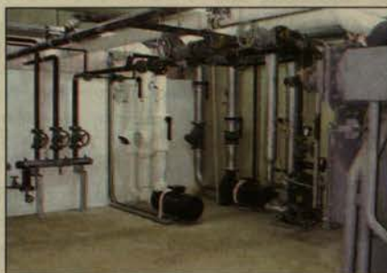
Εγκαταστάσεις παραγωγής ψυχρού νερού, διανομής νερού, επεξεργασίας νερού πλήρωσης.
