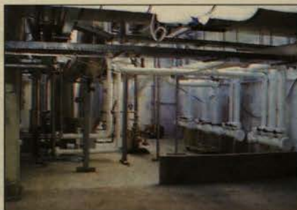
Εγκαταστάσεις ανάκτησης θερμότητας καυσαερίων, παραγωγής και διανομής ατμού.
