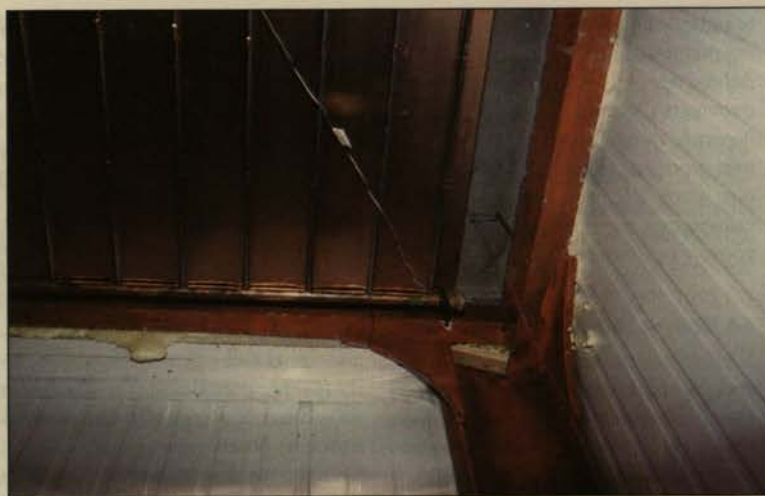
Σχήμα 2. Τμήμα μεταλλικού ψυκτικού πίνακα, τοποθετημένου στην κάτω επιφάνεια της πλάκας οροφής.
