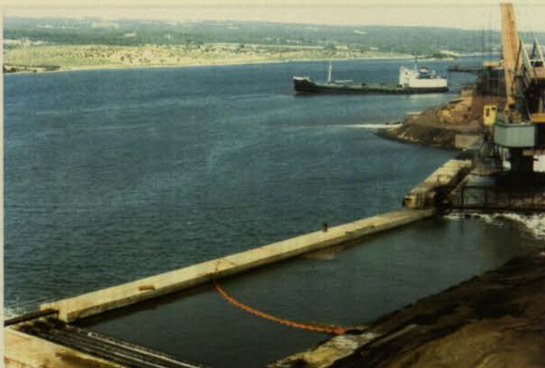
Φωτ. 1: Δεξαμενές καθίζησης σκουριάς ηλεκτοκαμίνων και γερανός διακίνησης.
