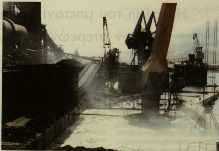
Φωτ. 2: Δεξαμενή καθίζησης και σύστημα διακίνησης (γερανός silos αποστράγγισης και ταμνοδρόμοι) σκωριάς ηλεκτροκαμίνων.
