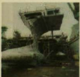
Σχ. 5, 6, 7. Κατασκευή γάστρας - HSS Stena Line
